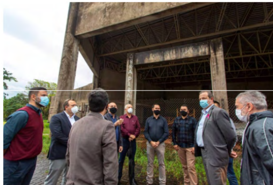
Obras do Teatro e Centro de Eventos estão paradas; prefeitos e superintendente apoiam retomada por parte do governo Foto: UEM
