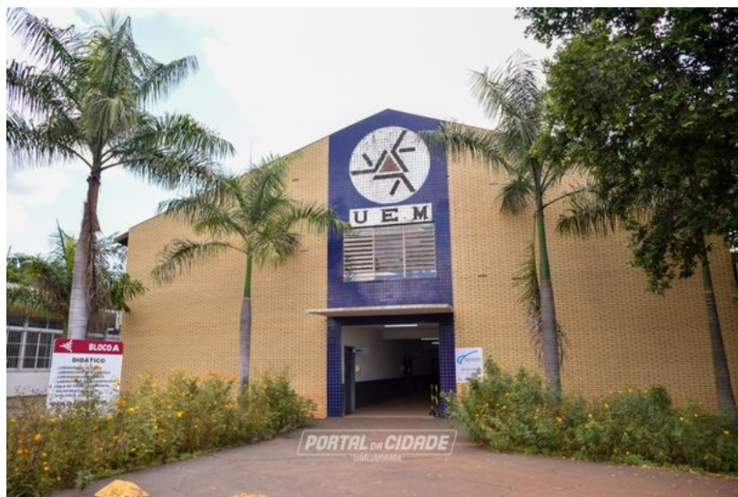
Administração da UEM completa três anos com retomada de obras em Umuarama (Foto: Portal da Cidade Umuarama/Gabriel Rocha)
