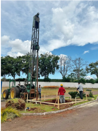
Obras de melhoria na infraestrutura estão sendo executadas na UEM de Ivaiporã
